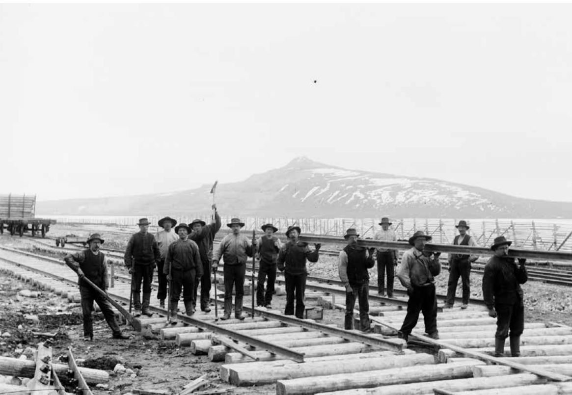
Rälsläggning vid Kirunas blivande järnvägsstation våren 1900. Foto: Borg Mesch, Kiruna kommuns bildsamling
