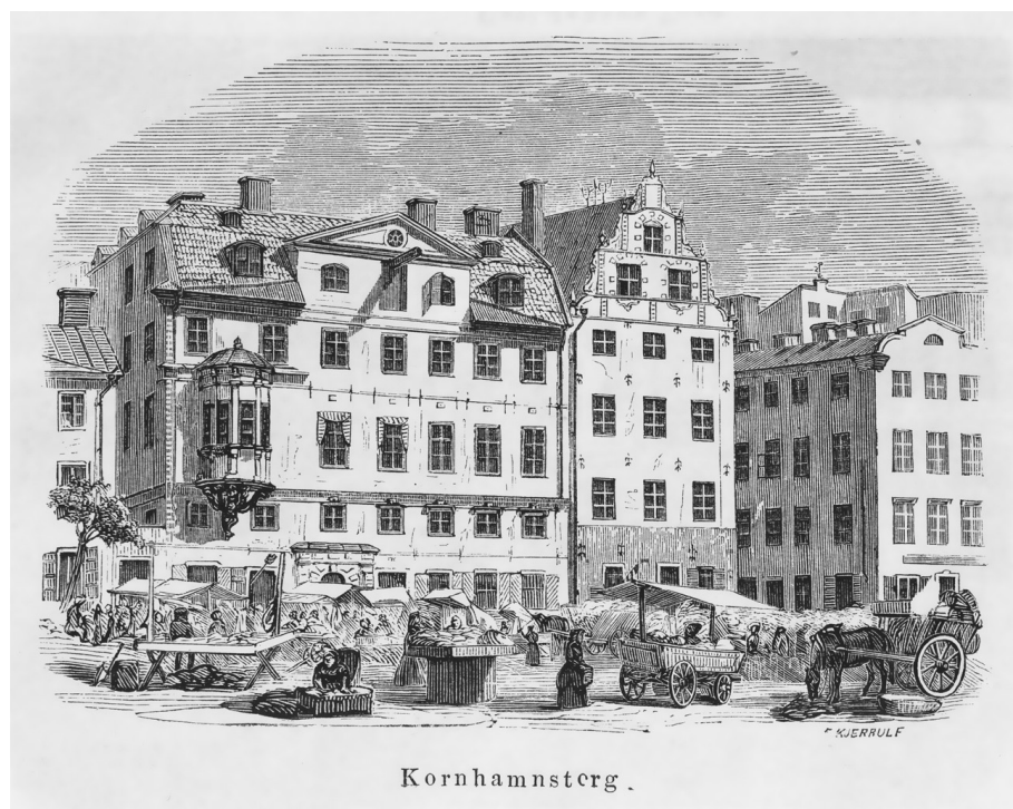
Fig.1. Det Scharenbergska huset vid Kornhamnstorg vid mitten av 1800-talet efter bild i Georg Scheutz, Stockholm. Illustrerade utkast (1860). Föreställningen om att Descartes bodde här har sannolikt sin grund i en gammal tro på att huset en gång varit avsett för Kristina. Foto: LUB.
